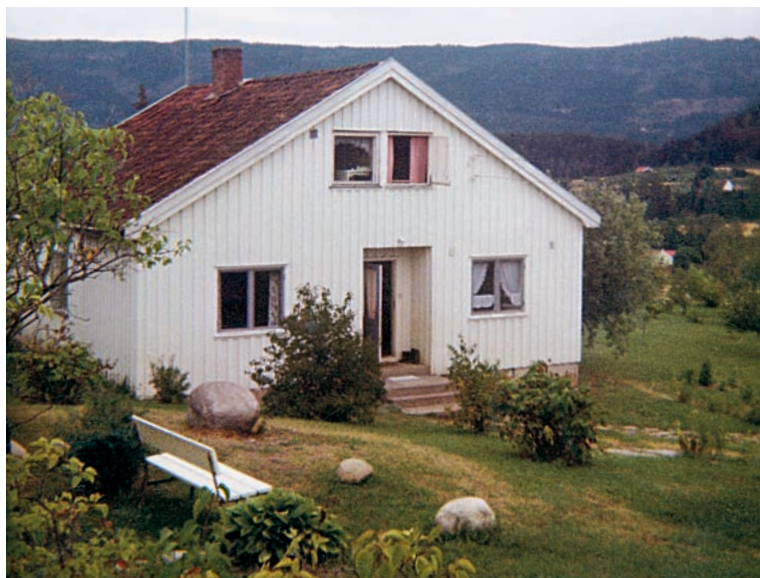
Våningshuset i Grindbakken etter ombygging 1950.
