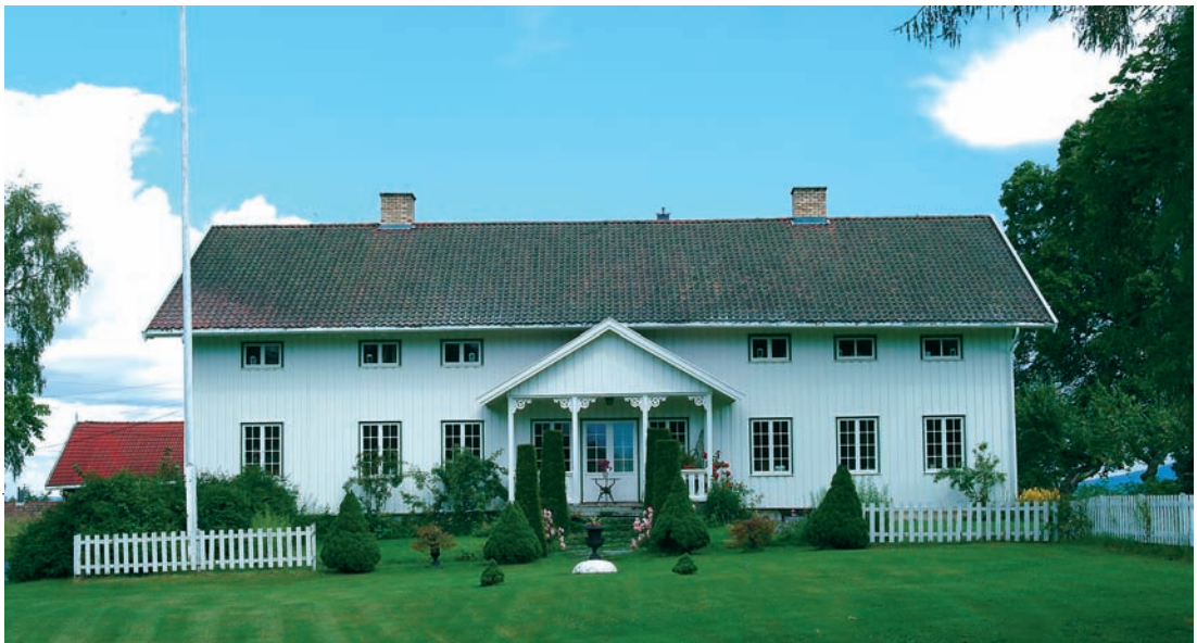
Hovedbygningen på Hole prestegård i 2004.
