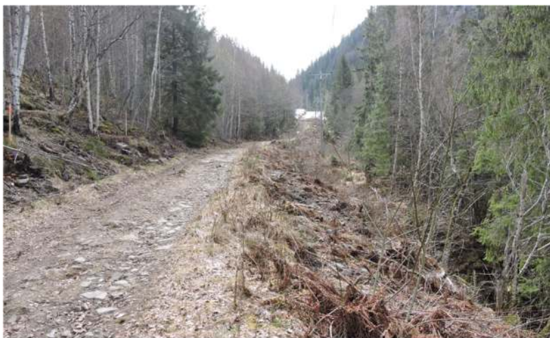
Figur 60: Mur 4 sett oppover mot Vanninga. Før istandsetting
