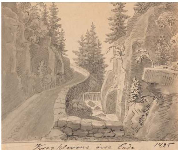
Figur 42: Tegning av Johannes Flintoe datert 1825 viser øvre del av Krokkleiva med brystningsmur mot skrent og bekk.
