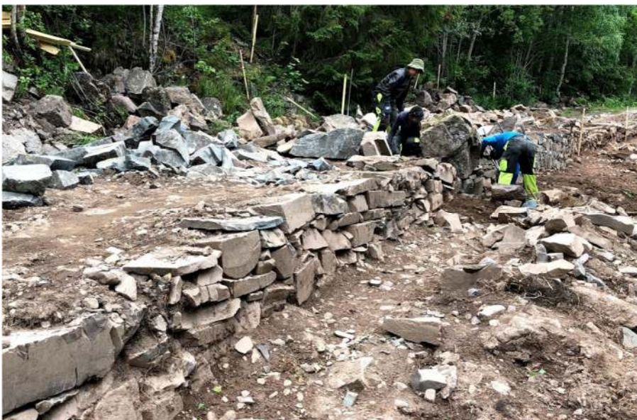
Figur 33: Istandsetting uten å demontere muren. Enkelte stein i toppskiktet skyves på plass, evt. suppleres med nye stein.
