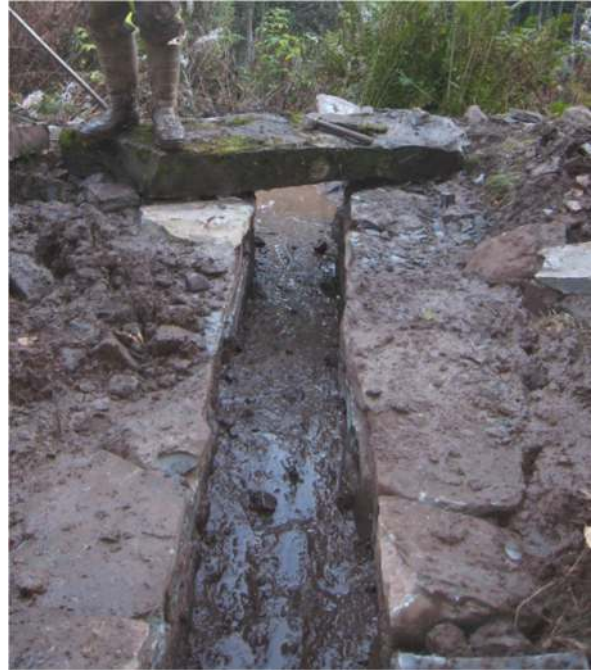
Figur 19: Istandsetting av stikkrenne.
