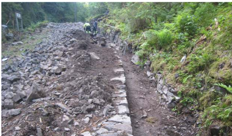
Figur 63: Rensk og restaurering av kantmur på vestsiden av Snobakken (pel 1030-1090)
