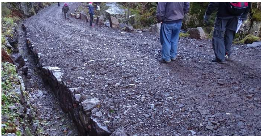
Figur 25: Toppdekke lagt på med naturgrus fra gammelt grustak langs Dronningveien.
