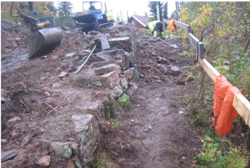
Figur 66: Ved pel 1370 er det bevart et lite parti av opprinnelig mur som ikke hadde rast ut.
