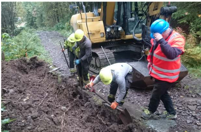
Figur 50: Avdekking av opprinnelig steinsatt vegkant.
