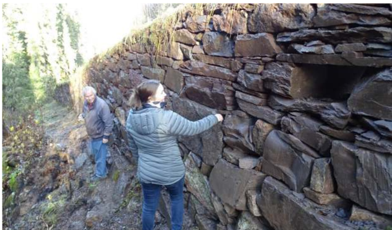
Figur 70: Mur 12 restaurert. Dreneringshull i brystningsmur sees til høyre.
