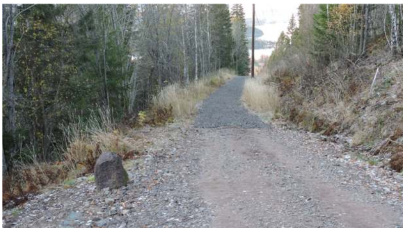
Figur 78: Temporær grus lagt ut i nedre del av kleiva fram til pel 540 (ved mur 4)
