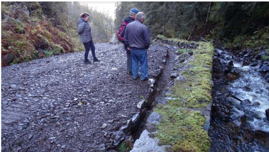
Figur 55: Mur gjenoppført som flomvern mot Kleivbekken. Grøft for drenering av vegbanen lagt på innsiden.
