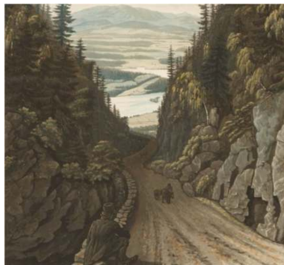
Figur 41: Samme brystningsmur sett nedover. Tegning av Wilhelm Maximilian Carpelan fra mellom 1819-1821. Kilde: Nasjonalmuseet NNMK.2016.0162
