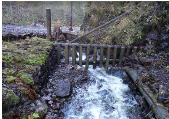
Figur 29: Nedre fanggrind utbedret, Ny ledemur i stein på venstre side.
