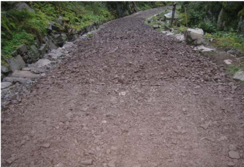
Figur 75: Grusmassene før og etter komprimering ved hjelp av beltegående dumper.
