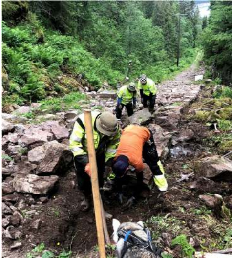
Figur 17: Kantmur graves fram og utbedres i Snobakken ca. pel 1060.
