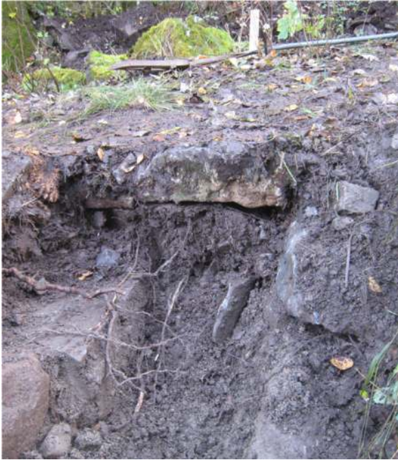
Figur 18: Eksempel på tett stikkrenne.
