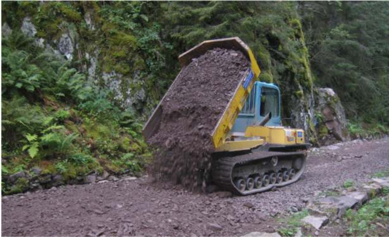
Figur 74: Grusmasser tatt ut fra gammelt grustak ved Dronningveien tippes fra beltegående dumper.
