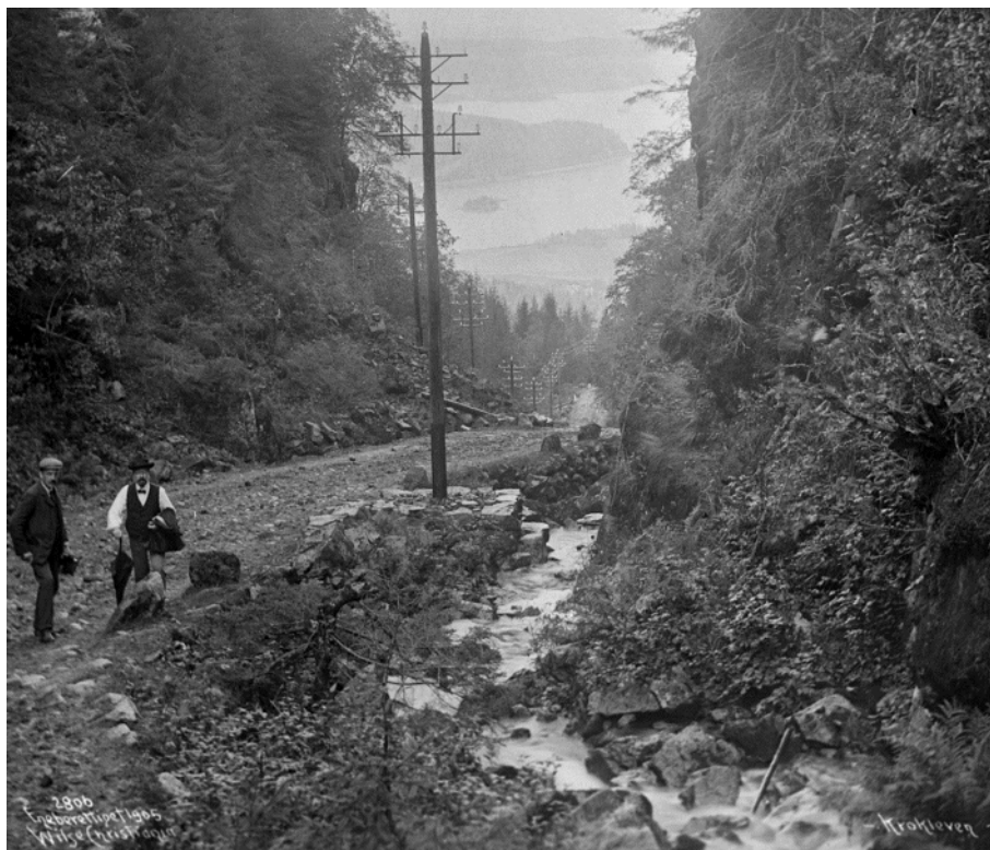
Figur 37: Foto fra 1905 viser telegraflinja som ble satt opp engang mellom 1892 - 1896. Legg merke til steinfundamentet for stolpen. Fotograf: Wilsé, Norsk Folkemuseum nr 9404-02310.
