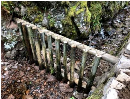
Figur 30: Øvre fanggrind ferdig utbedret.
