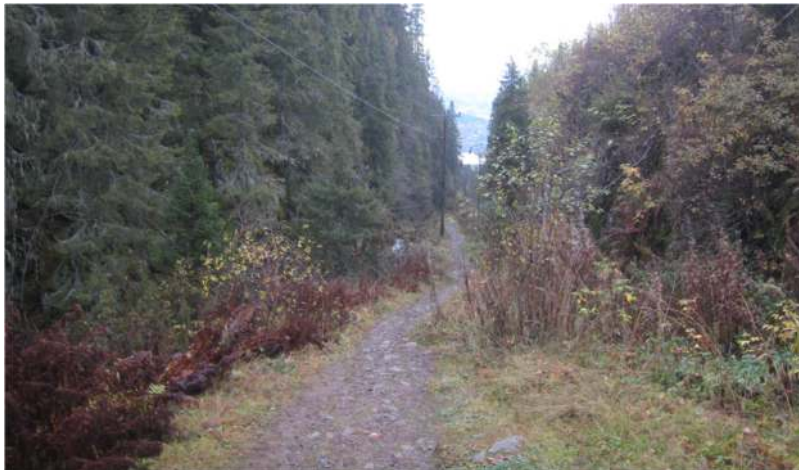
Figur 68: Den øverste, bratte bakken sett nedover før utbedring (ved pel 1340)
