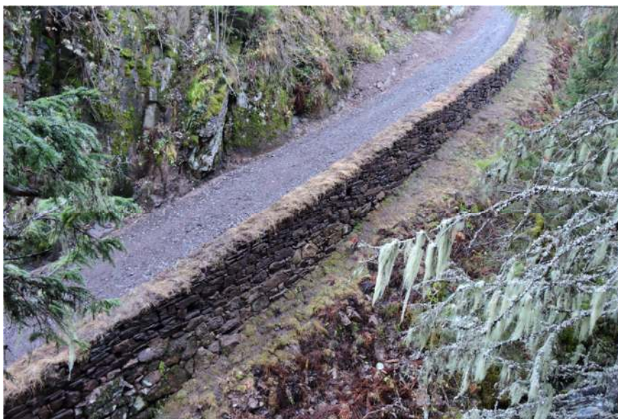
Figur 43: Mur 12 ferdig restaurert med brystningsmur. Bevarte partier av gammel mur sees i nedre del av muren.
