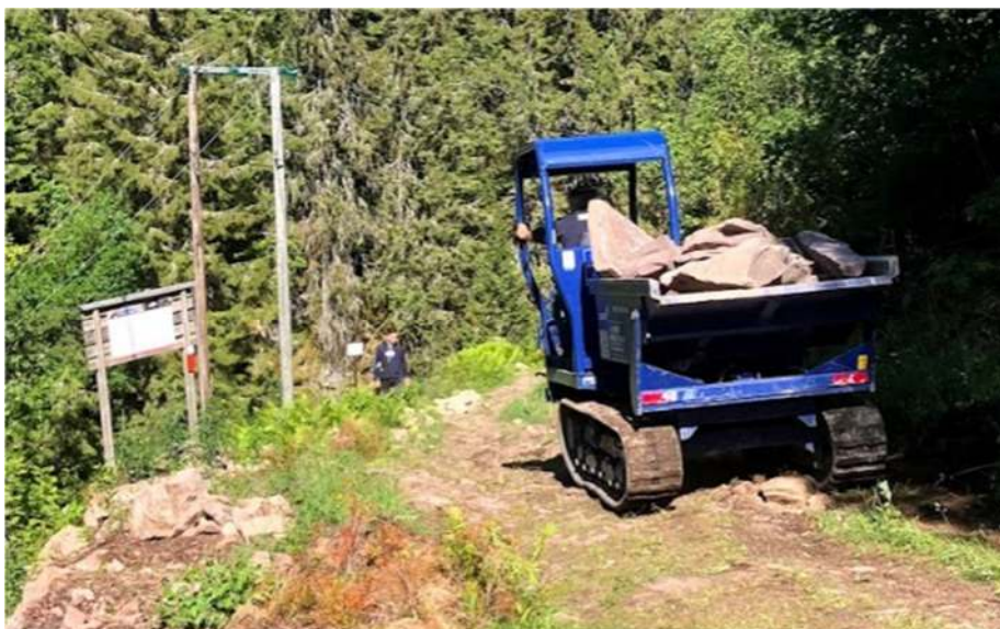
Figur 47: Beltegående dumper frakter stein ned den bratteste delen av kleiva.
