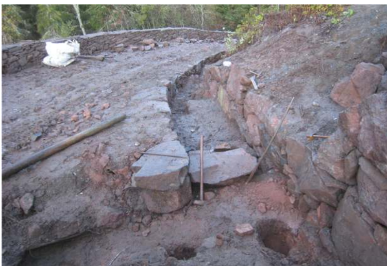
Figur 67: På toppen av kleiva er det boret hull i fjellet for solid innfesting av portstolper. Portstolpene er bare kilt fast med stein.
