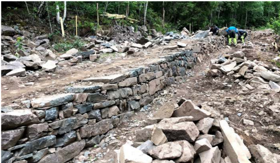
Figur 32: Gjenoppbygging (nærmest) og istandsetting (lenger bak) av mur 4. Sherpaenes yrkesstolthet kan være en utfordring. De legger mer flid i finishen enn de gjorde da vegen ble bygd.
