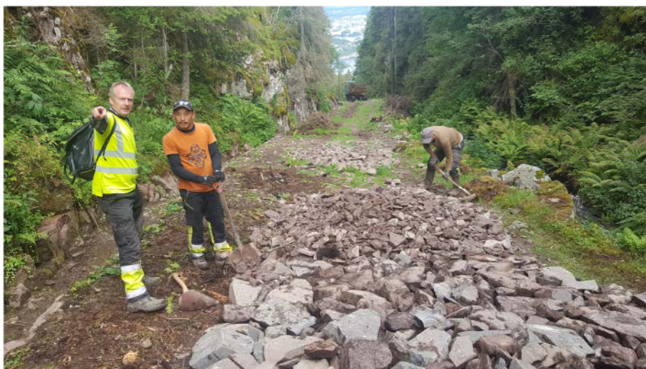
Figur 24: Vegprofilen bygges opp igjen med grov stein.
