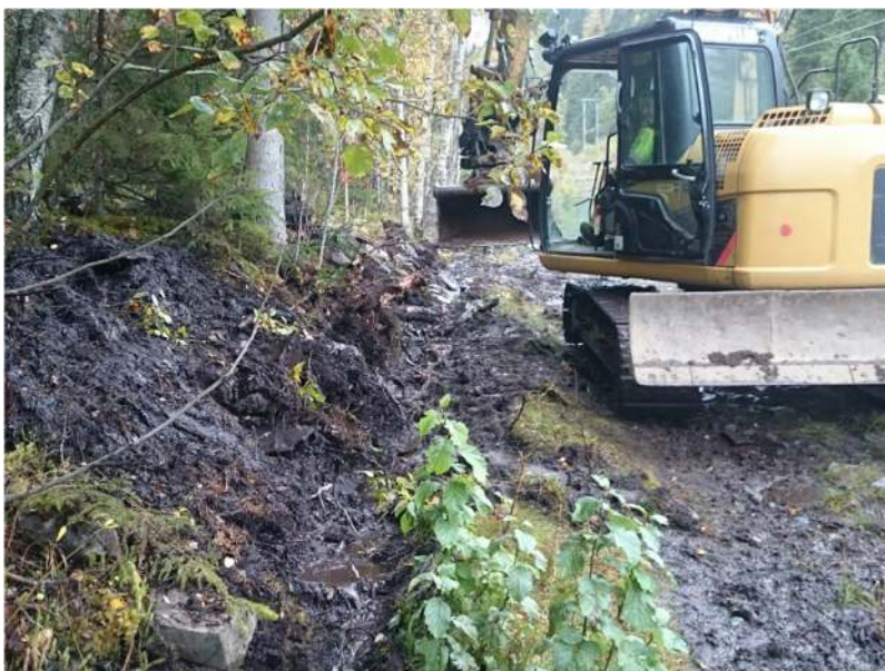
Figur 52: Maskinell rensk var nødvendig i grøfter med mye røtter. Sideterrenget har åpenbart glidd inn i- og over vegggrøfta i løpet av de 150 årene som har gått siden vegen var i ordinær bruk. Bildet viser et parti der vegggrøfta lå ca 30 cm høyere enn antatt vegbane. Det ble gjort manuelle stikkprøver for å se etter opprinnelig kantstein.
