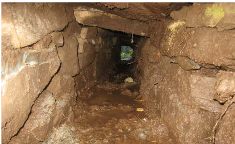
Figur 58: Original stikkrenne ved pel 658 trengte kun en opprensning.
