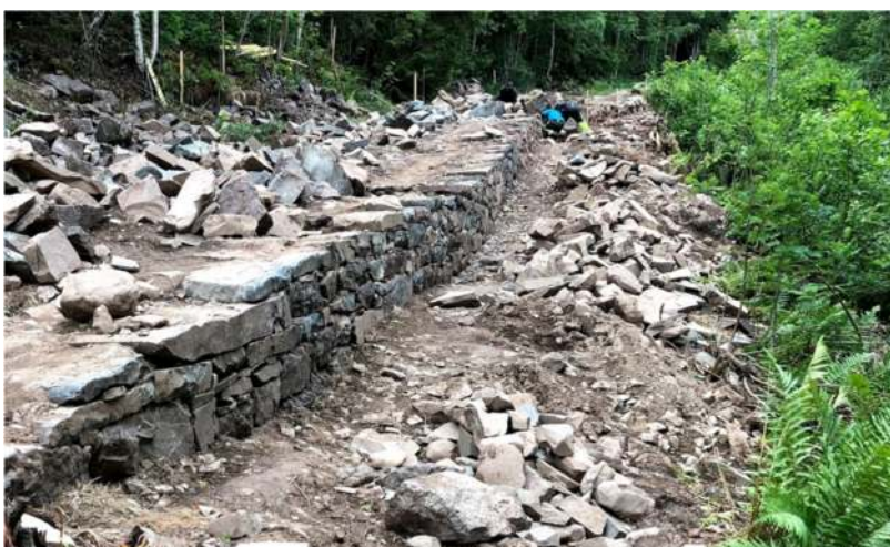
Figur 61: Mur 4 under restaurering, sett oppover fra pel 540.
