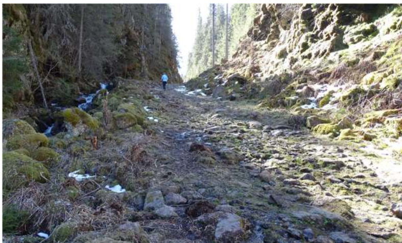
Figur 56: Snobakken før og etter istandsetting. Bakken var svært steinete og hadde oppkomme av vann midt i vegbanen.
