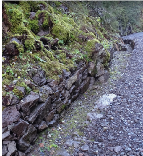
Figur 16: Enkelte steder måtte det bygges ny støttemur mot sideterreng for å gi rom for gjenåpning av grøft. Torv og mose lagt på plass igjen.
