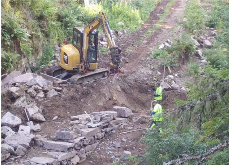
Figur 65: Rekonstruksjon av mur 12 ved pel 1220. Legg merke til hvor lite som er bevart av opprinnelig mur videre oppover bakken.
