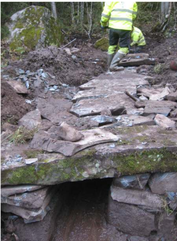
Figur 20: Ferdig utbedret stikkrenne.
