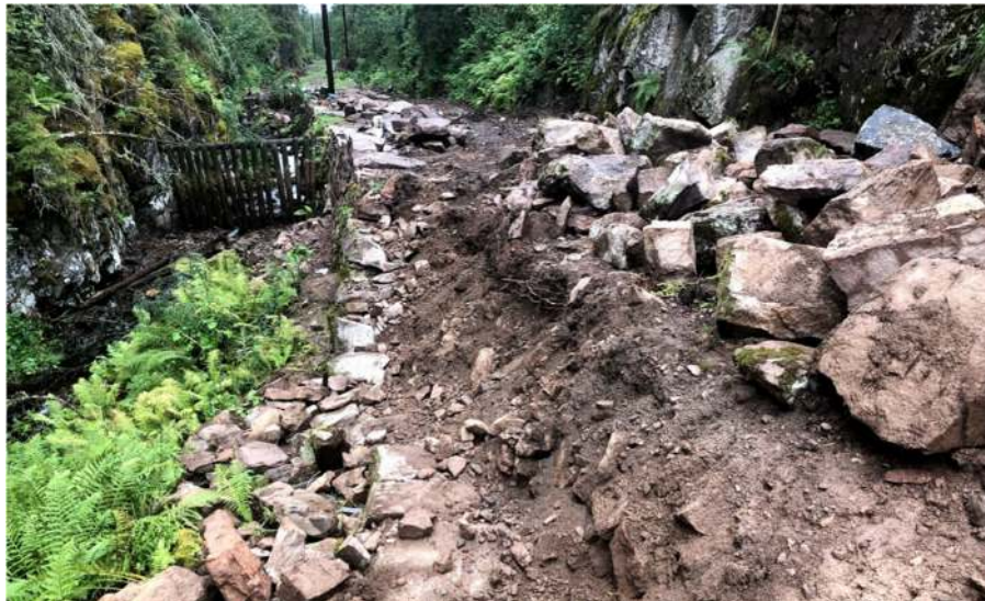
Figur 35: Muren etter demontering. Legg merke til hvor grunn murdybden er i bunnen, tilross for en høyde på over 2 m. Fyllmassene består i tillegg av mye jord med dårlig drenering.
