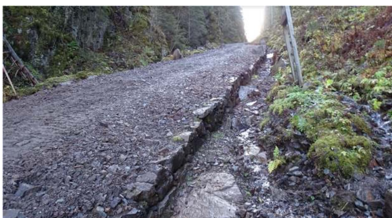
Figur 57: Snobakken etter restaurering i 2018 og 2019. Grøft på høyre side av vegen fanger opp liten bekk fra fjellskrenten lenger oppe. To nye stikkrenner (markert med stabbestein) drener vann vekk fra vegkroppen. Gammel infotavle til høyre må fornyes og gis en bedre plassering.
