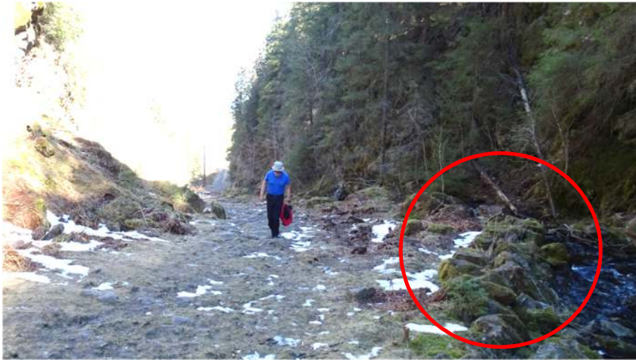
Figur 54: Toppen av Snobakken ved pel 1120. Rester av opprinnelig mur mot Kleivbekken sees i forgrunnen.
