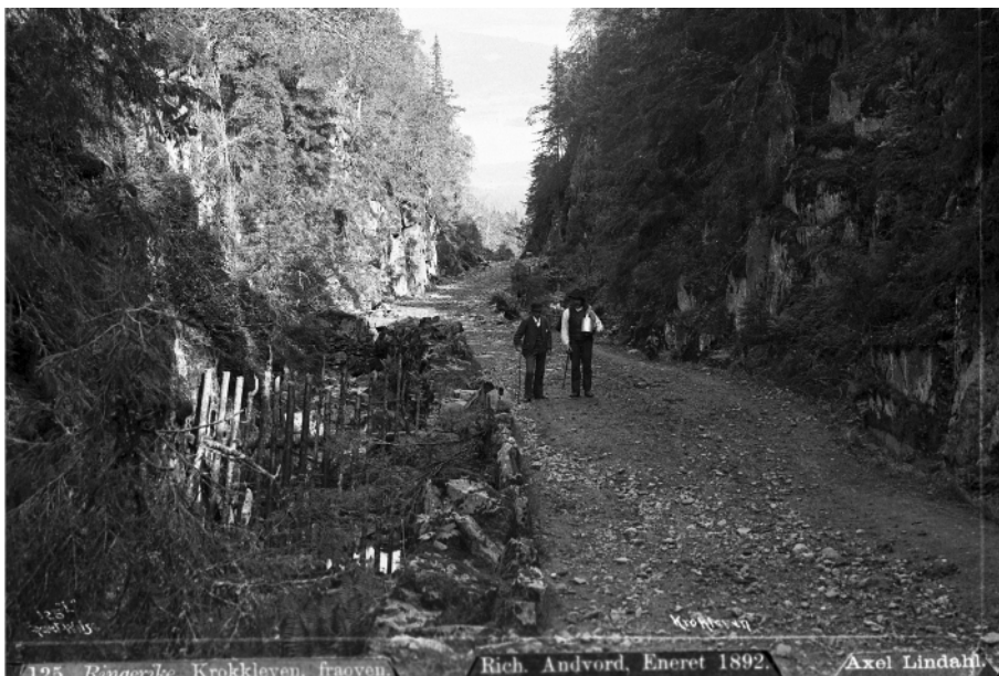
Figur 26: Parti ved øvre fanggrind (pel 1300). Legg merke til grusdekke på veggen, samt rester av brystningsmur på venstre side. Foto fra 1892 av Axel Lindahl. Kilde: Norsk Folkemuseum nr 9312-00143.
