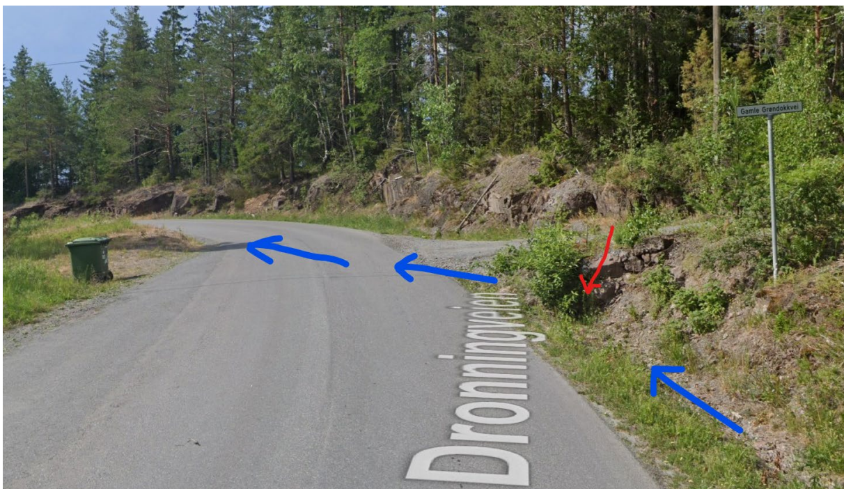
Figur 03. Bilde (Google Streetview) fra kartpunkt «B» ved Dronningsveien, som viser kulvert under Gamle Grønndokkevei. Vanlig bekkeløp/grøft nederst til høyre i bildet, blå piler viser vannets retning under hendelsen i august 2023.
