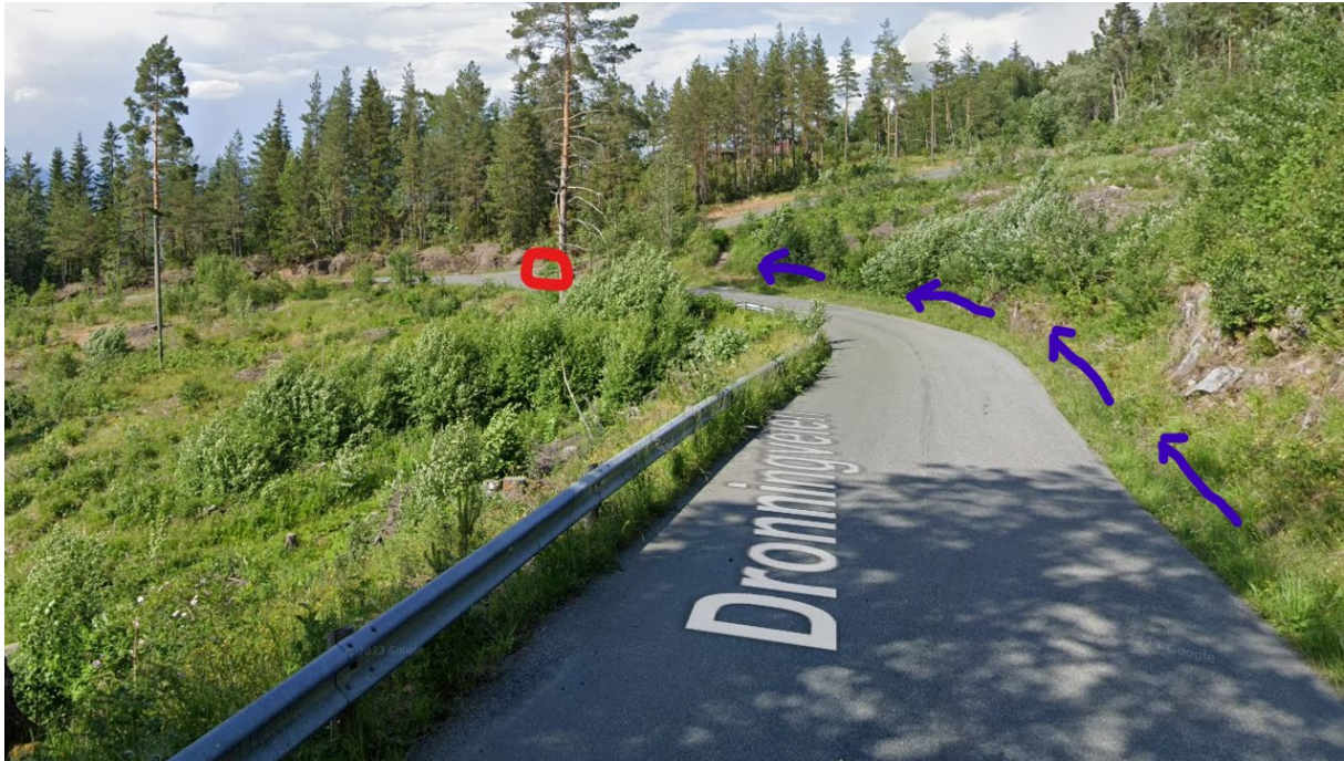
Figur 04. Bilde (Google Streetview) av Dronningveien på strekningen oppstrøms stikkrennen. Stikkrennen er vist med rød markering, bekke-/grøfteløp med blå linje/pil. Ved for liten kapasitet renner vannet over Dronningveien og ned i feltet til venstre på bildet.
