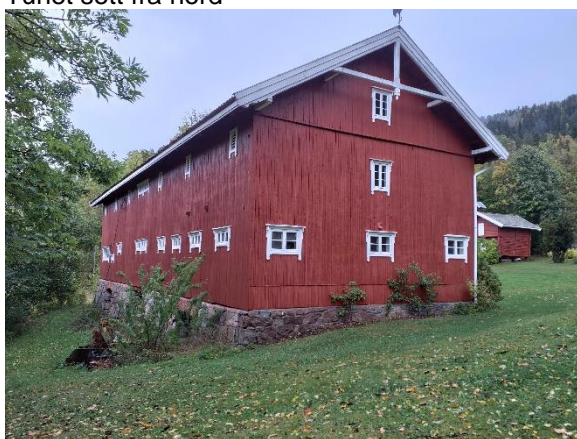
Driftsbygningen sett fra sør
