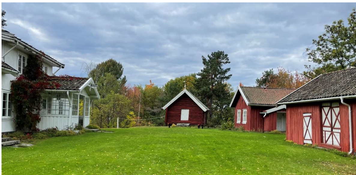
Tunet med våningshuset til venstre, stabburet, drengestue og uthus til høyre.
