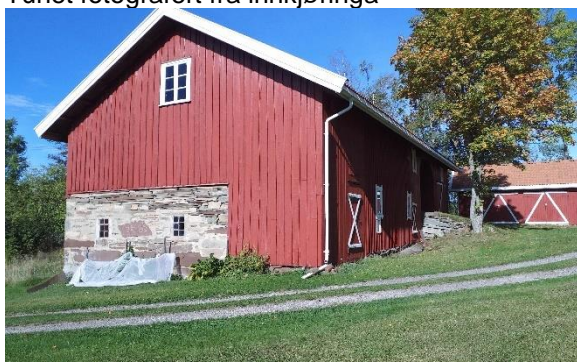
Driftsbygningen med fjøsdelen i naturstein.
