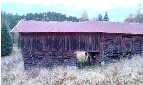
Søndre del av driftsbygningen, fasade mot øst
